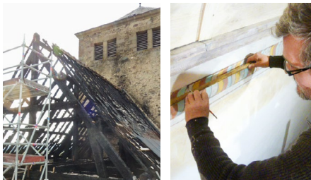
▲ Tout en haut : l'église avant l'incendie, en haut : les travaux de restauration
